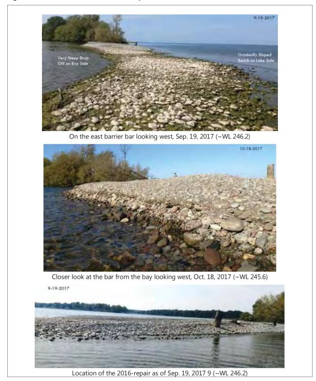
Figure 2.1-11 East Barrier Bar Breach, Sep. – Oct. 2017
